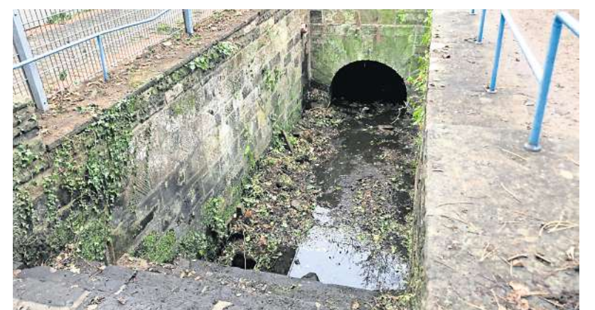
Der Mühlenbetriebsgraben ist wegen der Arbeiten derzeit teilweise ohne Wasser.
